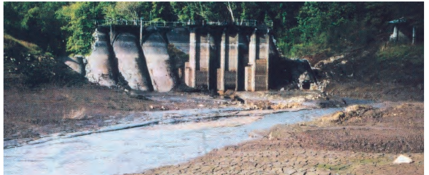
Fig. 6 Barrage de Kernansquillec en cours de démolition après la vidange.
