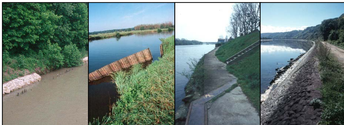
Figure 1. Illustration de quelques dispositifs "classiques" du génie civil en protection de berges de voies navigables (photos Biotec).
