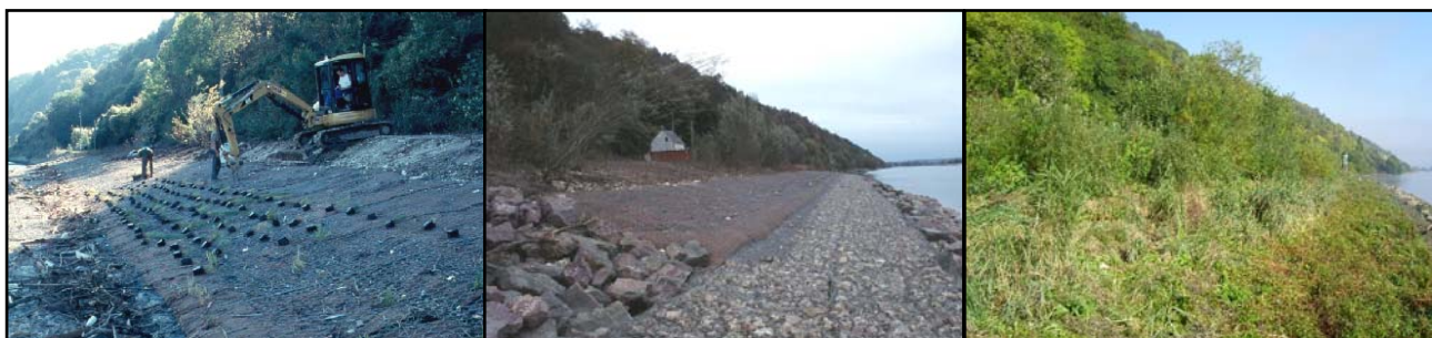
Figure 7. A gauche, plantation des hélophytes en cours, octobre 2005. Au centre, vue d'ensemble de la section réaménagée en fin de travaux (novembre 2005). A droite, développement végétal 2 ans après les travaux (septembre 2007) (conception des dispositifs et photos : Biotec).
