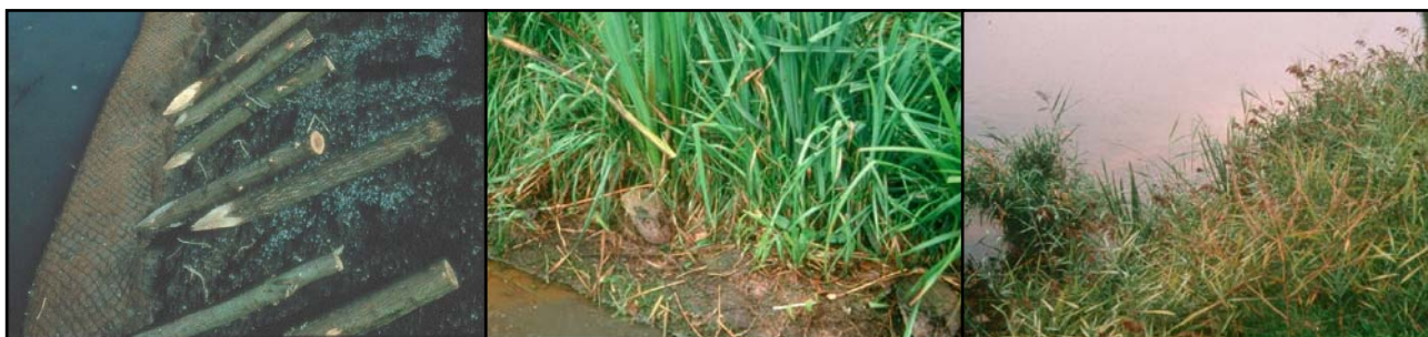
Figure 4. Fascine d'hélrophytes en construction sur la Lys en mars 1995 à gauche puis développement des végétaux 6 mois plus tard (détail au centre et vue générale à droite) (conception des dispositifs et photos : Biotec).
