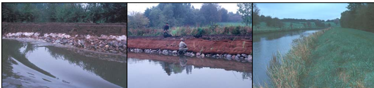
Figure 5. A gauche et au centre, détail de la réalisation en cours avec le calage des enrochements juste au-dessus de la vague de battillage et la plantation des végétaux hélrophytes (septembre 1998). A droite, développement végétal 3 ans après les travaux (octobre 2001) (conception des dispositifs et photos : Biotec).
