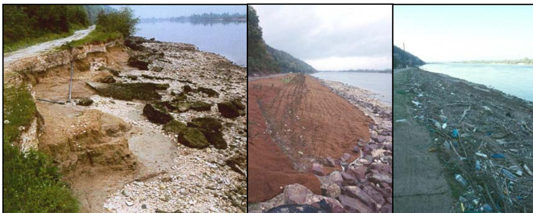
Figure 6. A gauche, état de la berge avant travaux en septembre 2000. Au centre, en fin de travaux (novembre 2001). A droite (mars 2002), où l'on peut aussi observer les nombreux déchets abandonnés par la marée, la Seine drainant un bassin versant de plus de 15 millions d'habitants !
