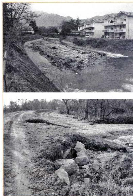
▲ Figure 10 - En haut : endiguement en béton sur les deux berges en zone urbanisée. En bas : digue en enrochements + remblai (sapé par déversement) en zone rurale (la rivière est à gauche).
