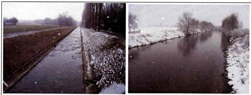
Figure 6. Exemples de cours d'eau recalibrés, rectifiés et endigués (voire bétonnés, photo de gauche en Suisse) (photos MALAVOI)
