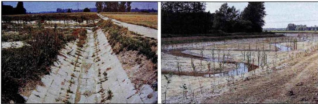
Figure 20. La Sulzbächle avant et après restauration (1990) [Handbuch Wasserbau, 1992]
