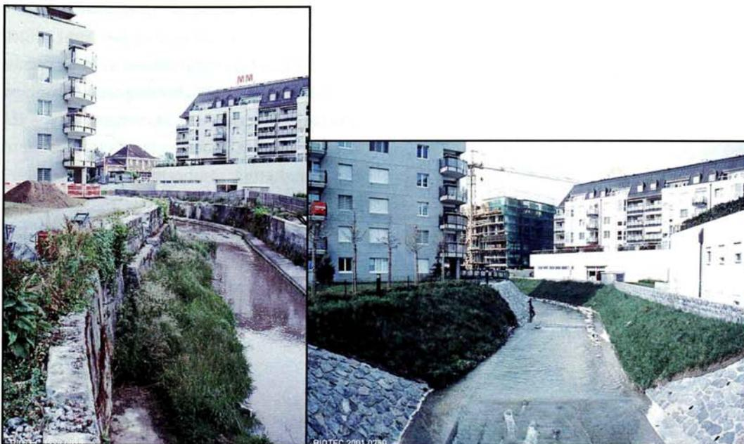
Figure 17. Exemple d'élargissement hydraulique d'un cours d'eau et réaménagement du lit sous forme de petits seuils, végétalisation partielle des berges, etc. Photo de gauche état initial, à droite deux ans après les travaux (photos BIOTEC)
