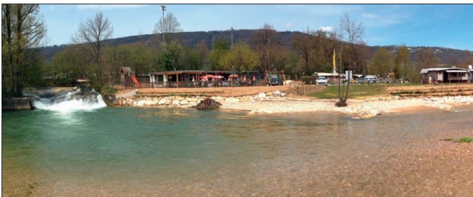
Fig. 11 : L'aménagement d'une zone d'accès à l'eau dans le camping de Delémont a été réalisé en bordure de la fosse du seuil de la Grande Ecluse. Pour garantir le maintien de la plage de graviers, des épis ont été mis en place (photo Biotec, avril 2012).
