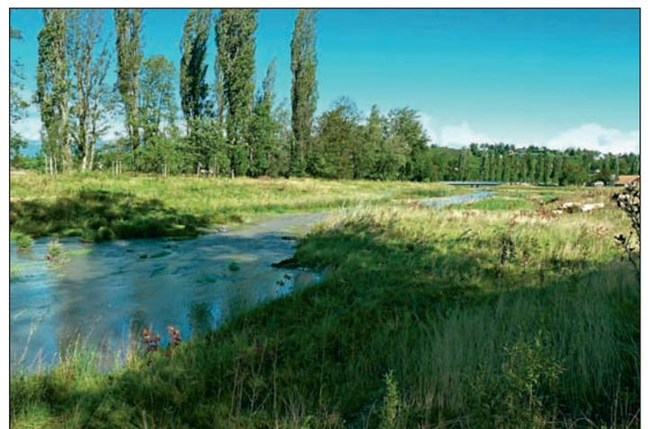
Fig. 5 : Nouveau lit de l'Aire, libre de s'écouler dans un important espace de liberté, végétalisé à l'aide des techniques du génie biologique ; une dizaine de mélanges grainiers particuliers pour les herbacées et 9 listes de plantes pour les ligneux ont été développées et utilisées pour la végétalisation de plus de 100 000 m<sup>2</sup> (photo Superpositions).
