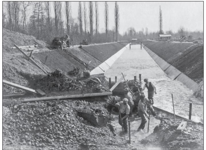
Fig. 12 : Travaux de correction de l'Aire dans les années 1930 sur le secteur de la 3<sup>e</sup> étape de revitalisation ; les anciens méandres ont été supprimés au profit d'un canal en béton rectiligne qui sera, à son tour, abandonné de la rivière (source : archives du canton de Genève).
