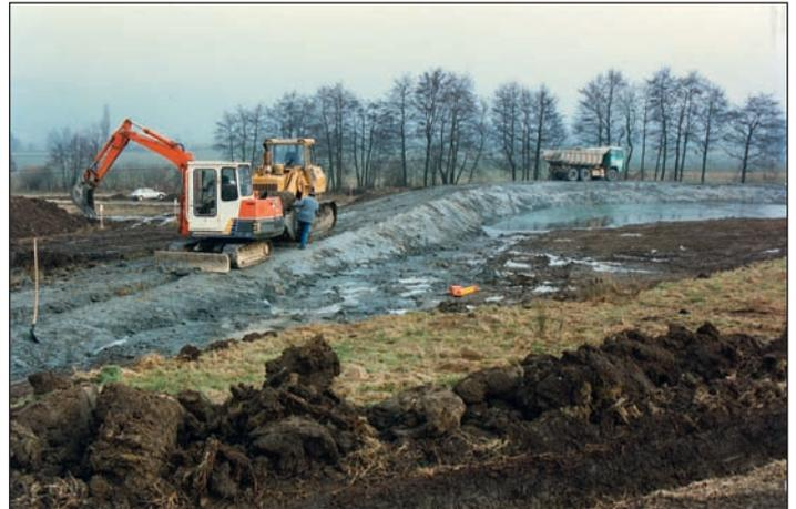
Fig. 7 : Construction de la digue de l'étang pour retenir l'eau provenant des drains détruits en amont (photo Biotec, 1996).
