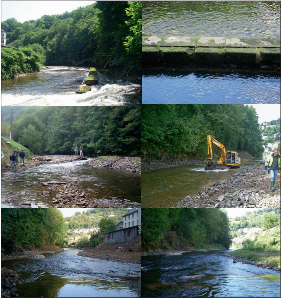
Fig. 11 : Vues successives du dérasement du seuil du « Pont des Soldats » sur la Corrèze à Tulle (photos Biotec).
