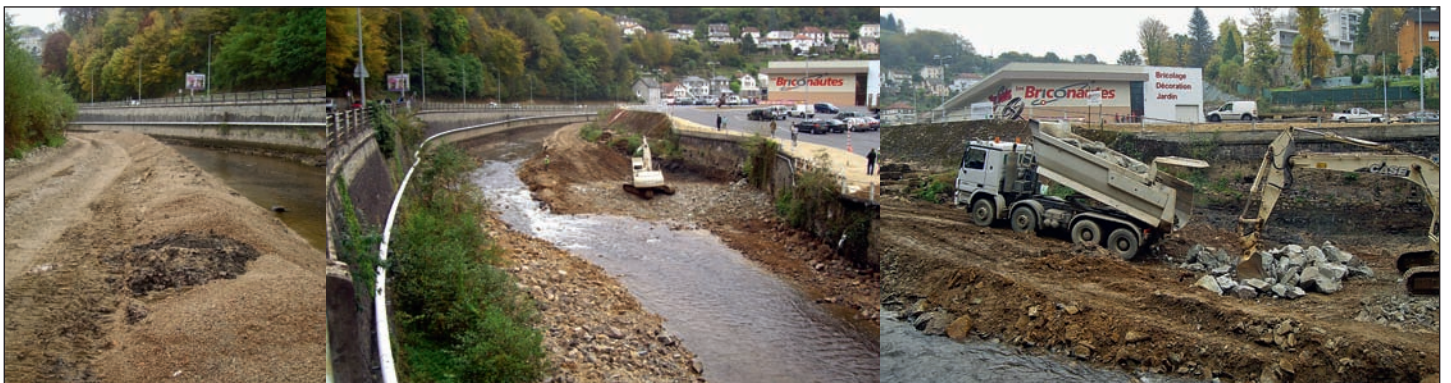
Fig. 7 : Terrassement en déblai/remblai des sédiments de l'ancienne retenue, accès au seuil et constitution d'une rampe en enrochements en lieu et place de l'ouvrage arasé (photos Biotec).
