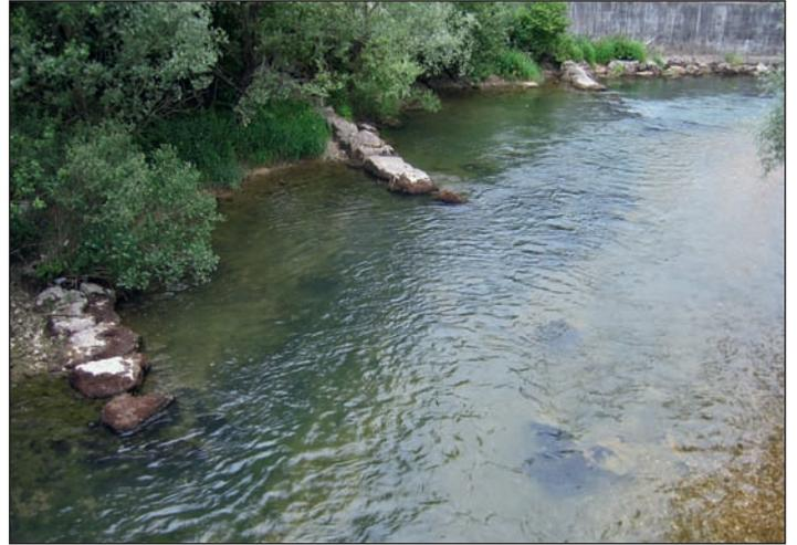
Fig. 4H : 2005. Vingt ans après les travaux, les épis sont toujours là et jouent infatigablement leur rôle de déflecteur. Des surprofondeurs existent entre les épis et la RG se végétalise de plus en plus favorisant un milieu diversifié pour la faune terrestre et aquatique.
