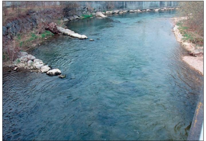
Fig. 4D : 1996. Malgré des crues successives importantes depuis la fin des travaux (1985), on constate que le banc de galets ne grossit pas et que les épis ont favorisé le dépôt de matériaux fins en rive gauche, au pied des enrochements, ce qui permet à la végétation spontanée de s'installer.
