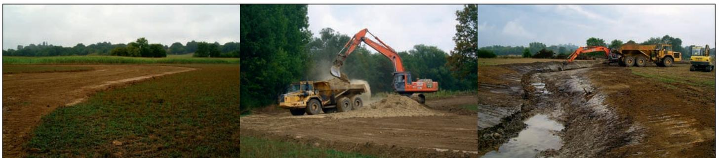
Fig. 5 : Premiers terrassements du nouveau lit. Pour mémoire, la totalité des « déblais » du nouveau lit a été déversée en trois points particuliers du plan d'eau au plus proches des terrassements, pour limiter toute évacuation en décharge et de multiples transports en camion (photos Biotec).
