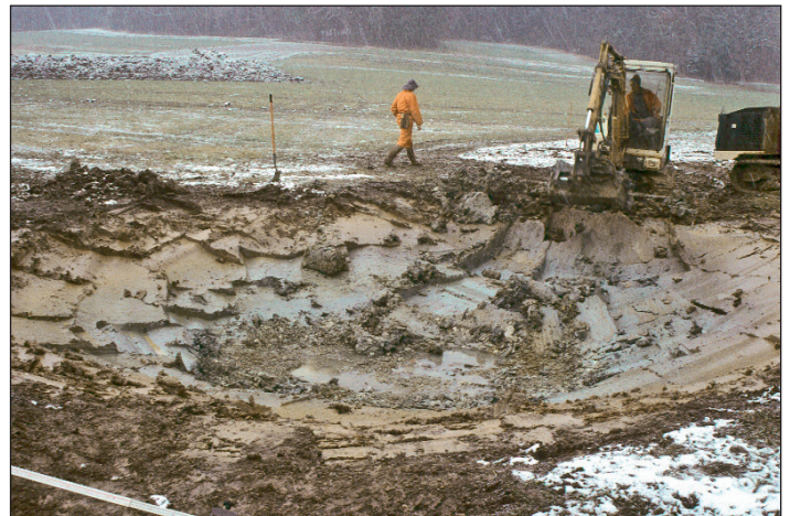
Fig. 4 : Creusage de nombreuses dépressions afin de créer des mares plus ou moins profondes (photo Biotec, 17.02.1993).
