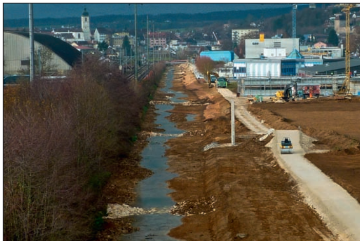
Fig. 4 : Espace mis à disposition de l'Allaine dans un secteur actuellement sans construction mais inscrit en zone industrielle (premier plan). L'emprise à disposition de la rivière et de ses berges est passée de 11 à 25 m (photo Biotec).
