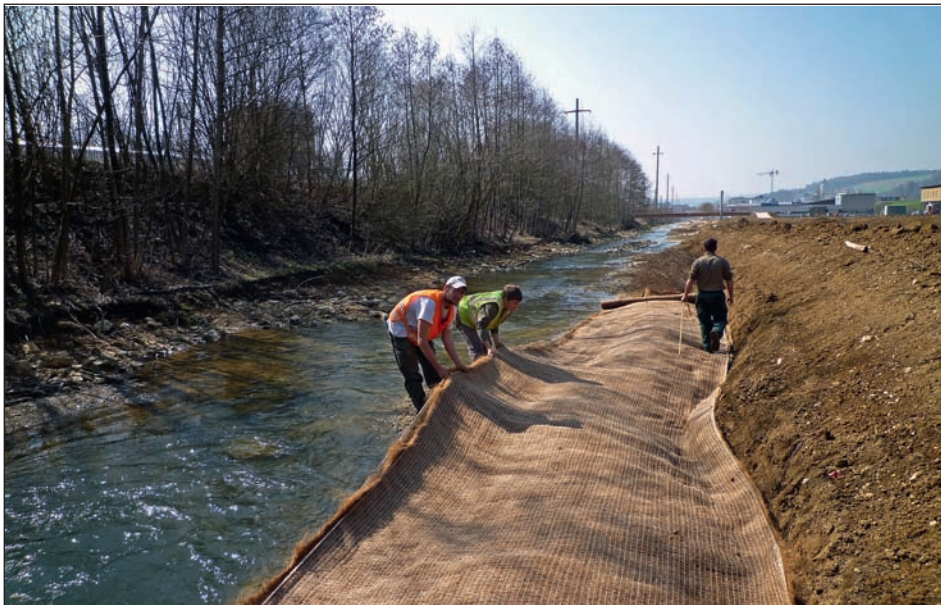
Fig. 10 : Réalisation du « sac » en géotextile biodégradable (coco) formé d'un feutre et d'un filet pour stabiliser le pied de berge à l'arrière des terrasses érodables (photo Biotec).
