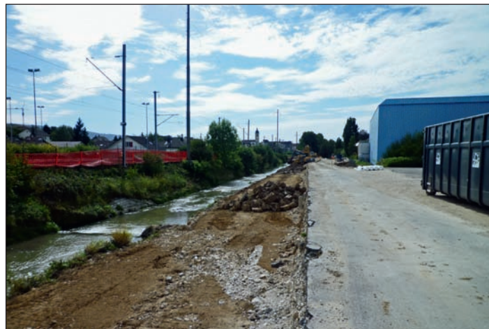
Fig. 5 : Dans le secteur déjà bâti, l'espace redonné au cours d'eau a impliqué la démolition d'une route, la redéfinition des circulations dans la zone industrielle et le déplacement d'une batterie de câbles électriques de très haut voltage (photo Biotec).
