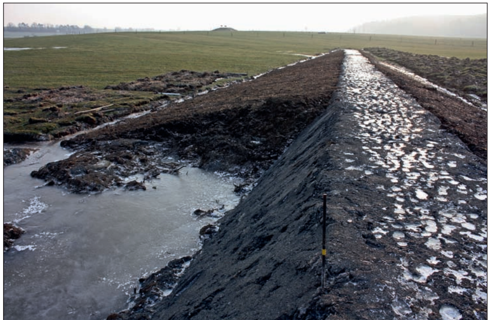
Fig. 7 : Illustration d'un prolongement de digue en travaux. On distingue au premier plan le noyau de marnes à opalines et en second plan le talutage final avec des matériaux terreux du site (photo Biotec).
