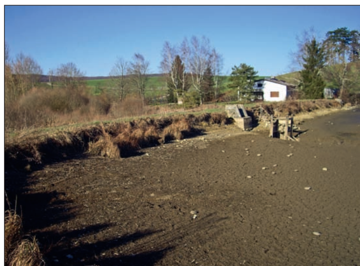
Fig. 4 : Etat très dégradé d'une des digues frontales avec ancien ouvrage de vidange (photo Biotec). Abb. 4: Sicht auf einen stark verfallenen vorderen Deich mit altem Abflussbauwerk (Foto Biotec). Fig. 4: Pessimo stato di una delle dighe anteriori con vecchia opera discarico (foto Biotec).
