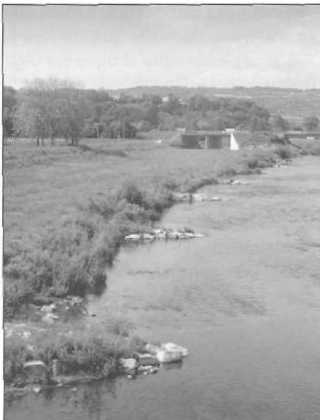
Figure 10: Trois ans après les travaux, l'ensemble des essences herbacées et ligneuses mises en place protège la berge et la rive de tout affouillement et retrouve des fonctions similaires à tout cordon végétal rivulaire naturel (28.5.2001).
