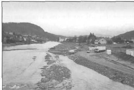
Figure 1 : Au centre de la Loire, on aperçoit l'emplacement du futur seuil mobile de fa Chartreuse. Au milieu de la photo, un bras secondaire, pour le déplacement piscicole, est «en cours de travaux». L'ensemble des sols de la plaine inondable n'est pas encore végétalisé (à droite sur la photo, 22.1.1997).
