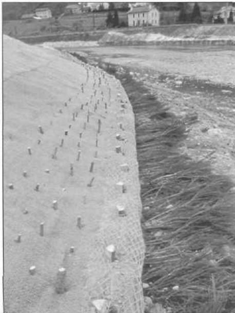
Figure 6: Mise en place des «fascines d'hélrophytes» en pied de berge durant la période de basses eaux. Elles sont constituées d'un boudin formé par des nattes biodégradables, géotextiles en fibres de coco, renfermant des matériaux terreux. Les herbacées hélrophytes sont ensuite plantées sous forme de mottes à l'intérieur du boudin. La fascine est maintenue au sol par une rangée de pieux et protégée de tout affouillement par dessous au moyen d'un lit de branches anti-sape (16.3.1998).
