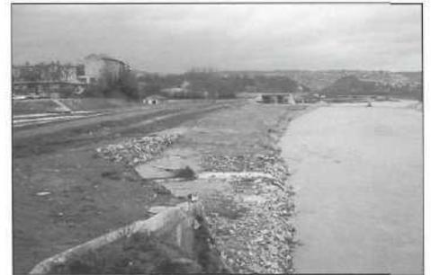
Figure 8: En aval du «Pont de la Chartreuse», on découvre les travaux en cours d'élargissement de la Loire, peu de temps après la crue de novembre 1996. En arrière-plan, on distingue l'ouverture hydraulique complémentaire [ouvrage de décharge] sous la route nationale RN 88 (22.1.1997).
