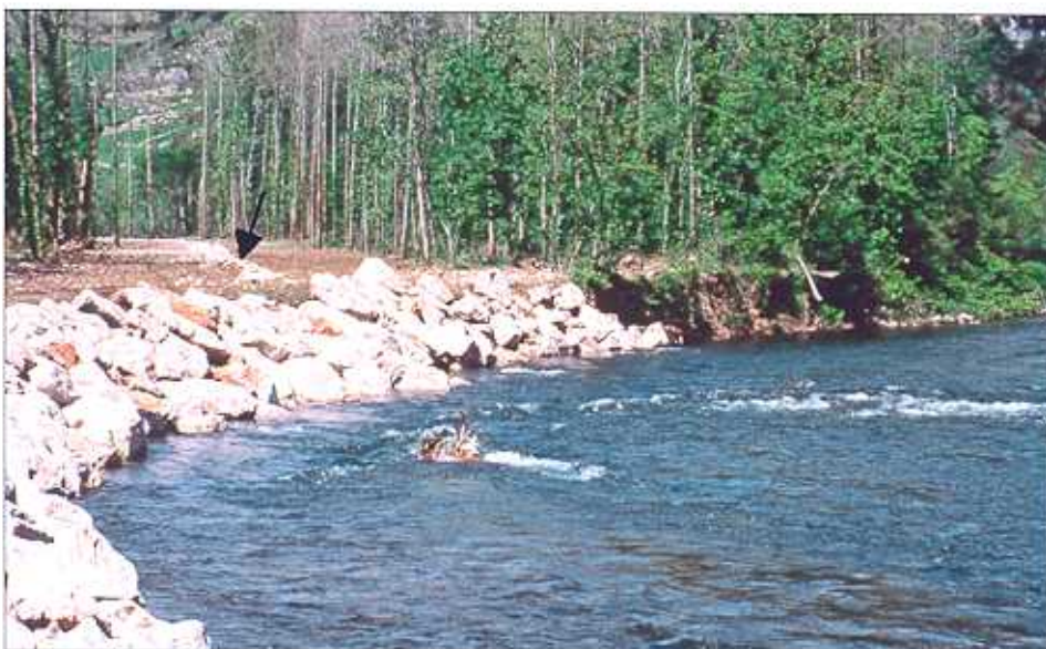
Fig. 7: Exemple d'enrochement effectué dans une zone alluviale en prévision d'une érosion hypothétique future! La bêtise, en construction de rivière, n'a plus de limite.
