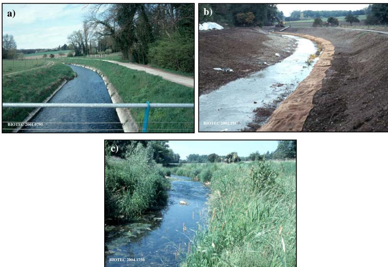
**Figures 7a-7c.** Revitalisation et décorrection de l'Aire à Genève (tronçon pilote).
