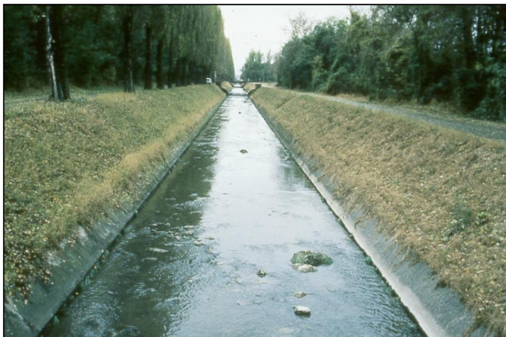
**Figure 3.** Chenalisation d'un cours d'eau. Aujourd'hui un projet de revitalisation complète est en cours (voir aussi fig. 7). Aire, Genève.
