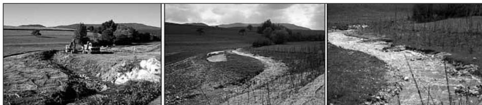
Fig. 2: A gauche, état initial après abattage des arbres et décapage de la terre végétale (14.08.01). Au centre, c'est uniquement l'arrière-berge qui a été stabilisée par la plantation de ligneux (18.04.02). A droite, on voit que le pied de la berge droite peut évoluer naturellement au gré du jeu des crues, de l'érosion et des dépôts (18.04.02) (Photos Biotec).
