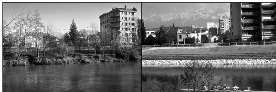
Fig. 6: Vue de l'érosion avant travaux à gauche et du profil «mixte» réalisé à droite (photos Biotec).
