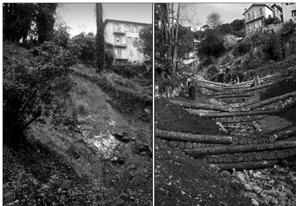
Fig. 3: A gauche, vue du site avant les travaux d'assainissement, avec un affleurement de gypse (07.04.98). A droite, barrages-bois en fin de chantier (10.03.99) (photos Biotec).
