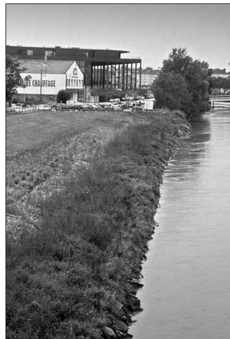
Fig. 8: Vue d'ensemble de la berge adoucie et réaménagée moins d'un an après les travaux (11.09.03) (photo Biotec).
