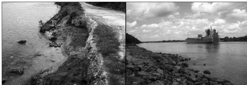
Fig. 2: Erosion de berge (à gauche) sur la Seine naviguée en aval de Rouen par des bateaux de grand gabarit (à droite) (photos Biotec).
