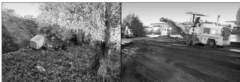
Fig. 7: A gauche, avant les travaux; présence d'un talus en remblais dégradés, d'anciens murs et de perrés (08.11.01). A droite, déroctage du bitume des quais avant leur démolition (14.11.02) (photos Biotec).
