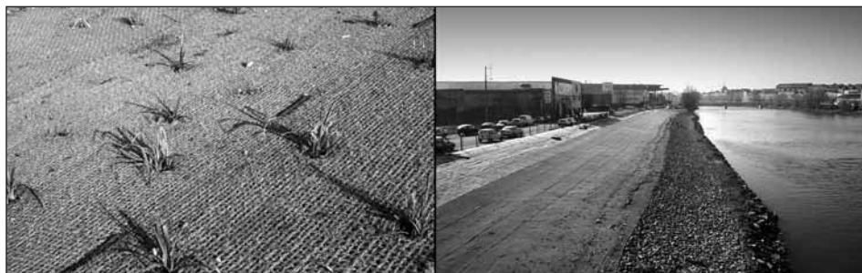
Fig. 9: Détail des hélophytes plantées à travers des géotextiles biodégradables à gauche et vue d'ensemble de la berge réaménagée à droite (19.03.03). Les cailloux posés en bas de berge servent à piéger la vase transportée par la Loire, substrat favorable au développement des Angéliques des Estuaires ( Angelica heterocarpa ), espèce végétale protégée à l'échelon international et endémique à la région Nantaise (photos Biotec).
