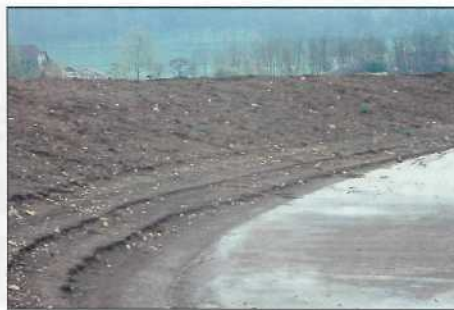
Figure 5: (12.04.01) Effet du batillage dû au vent sur la berge qui n'est pas encore protégée durant les essais de remplissage des étangs.
