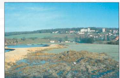
Figure 19: (25.01.01). Etat avant les travaux de terrassement. Au gauche de l'image, on note la présence des étangs de sécurité.
