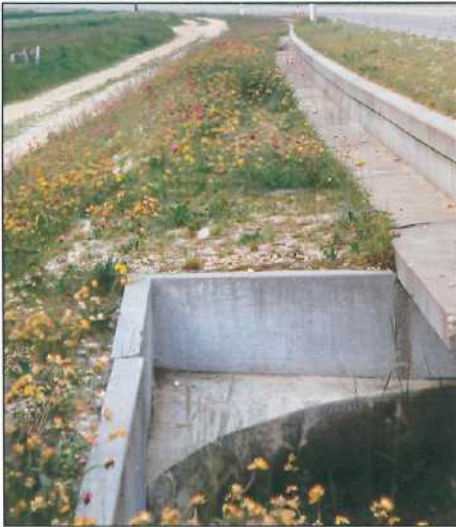
Figure 14: (28.05.03) Barrière anti-batraciens avec l'entrée d'un passage inférieur qui traverse la route d'accès à l'autoroute.
