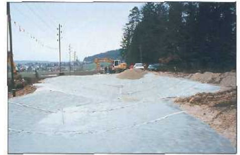
Figure 11: (04.03.99) Pose de la natte d'étanchéité dans le fond de l'étang, après le creusage et la mise en forme des berges.
