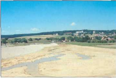
Figure 20: (21.06.01) Etat juste à la fin des travaux où l'on observe le lit mobile et méandreux formé dans un espace de divagation d'environ 20 m de large.
