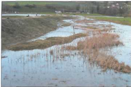
Figure 21: (14.01.04) En crue, l'eau peut se répandre sur toute la largeur, ce qui induit une faible hauteur d'eau et donc de faibles forces d'arrachement.
