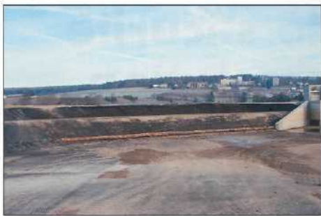
Figure 3: (27.02.01) Vue d'ensemble de la pose des rondins.
