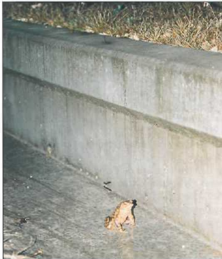
Figure 15: (20.03.02) Détail de la barrière anti-batraciens avec la migration d'un crapaud commun mâle.
