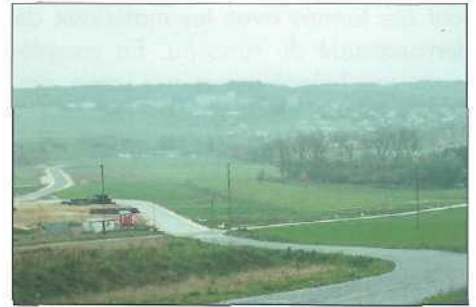
Figure 24: (02.11.99). Vue d'ensemble du site qui accueillera les bassins de sécurité et la forêt humide pour les batraciens.
