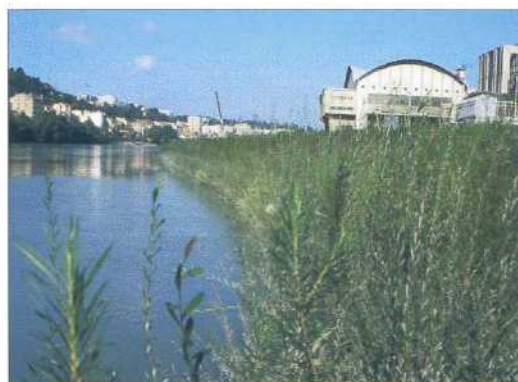
3. Vue d'ensemble de la protection de la berge, 6 mois après la fin des travaux. L'ancien palais des congrès et Interpol sont visibles sur la droite (27.9.94). ©Biotec
