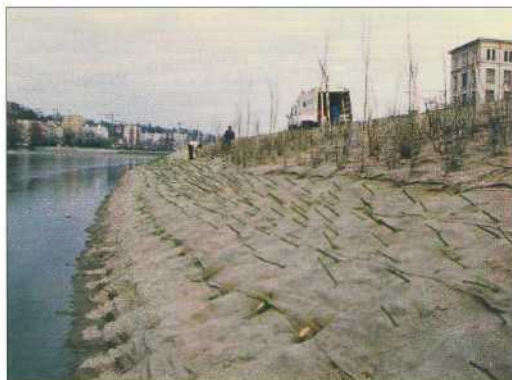
2. Fin des travaux portant surplus de 600 m de berge. Une répartition des lignieux a été opérée selon les séries végétales observables sur le Rhône (14.3.94). ©Biotec
