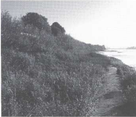
A gauche: Etat de la berge deux saisons végétatives après les travaux (vue amont). Le développement des héliophytes permet de retenir les vases lors du retrait de la marée. Cela contribue à structurer le paysage et à diversifier les séries végétales selon les modèles naturels (9.9.1999). A droite: En 2001 •
