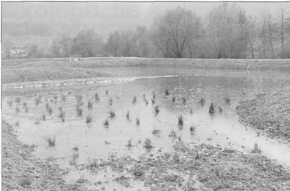
Figure 11 : Les mottes d'hélophytes ont été mises en place dans la partie amont du bassin pour favoriser la filtration et l'épuration naturelle des eaux (avril 1994).
