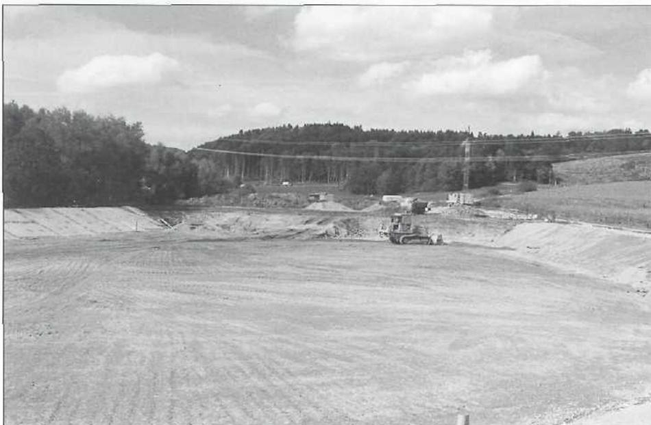
Figure 6: L'assise de l'étanchéité est réalisée. Les berges sont protégées provisoirement avec des feuilles plastiques avant la pose de la natte d'étanchéité (septembre 1993).
