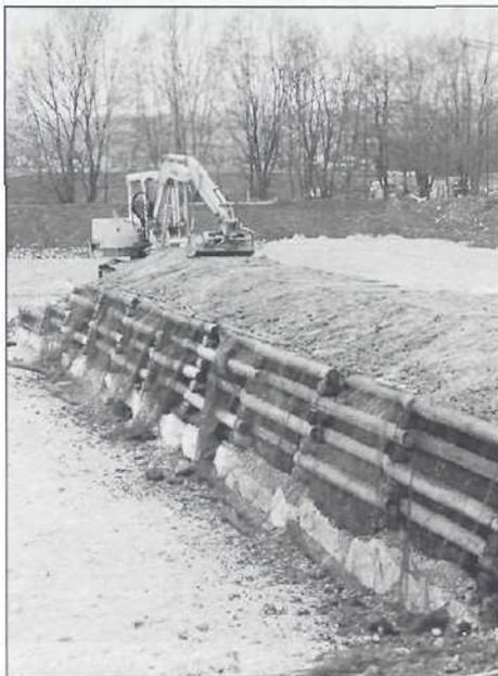
Figure 9: Mise en place de terre végétale sur les talus et réalisation de l'épi amont [caisson en rondins à double paroi, végétalisé, décembre 1993].
