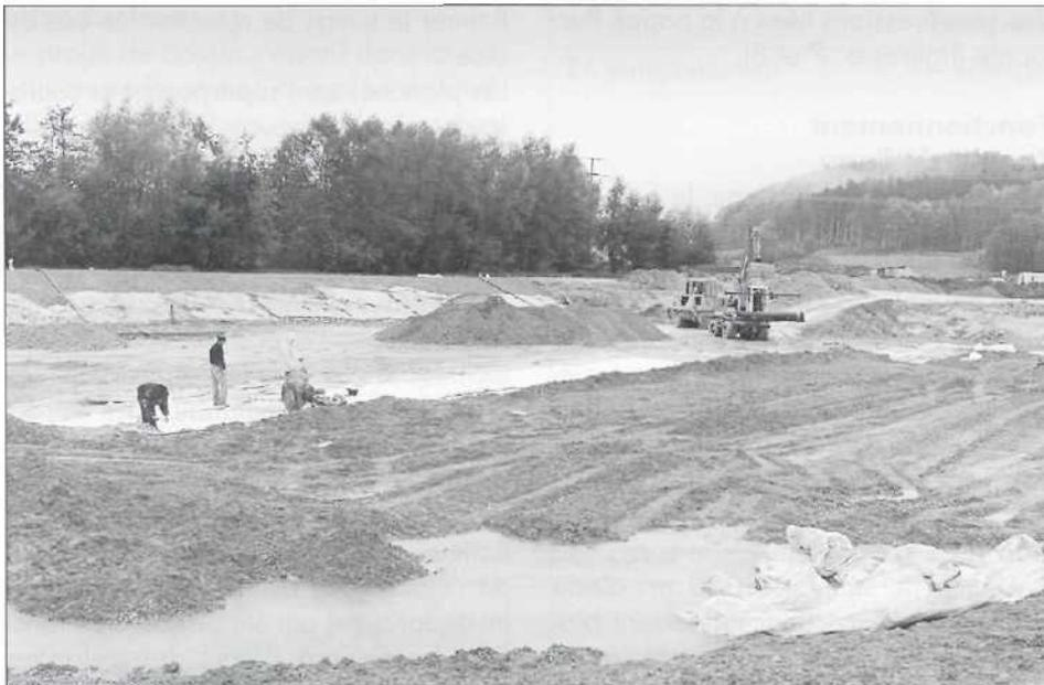
Figure 8: Lestage immédiat des nattes d'étanchéité posées à l'aide de matériaux graveleux [octobre 1993].
