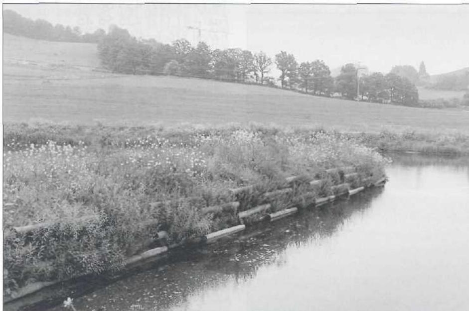
Figure 12: Durant la première saison végétative à suivre des travaux, les boutures mises en place dans le caisson en rondins se développent pleinement (mai 1994).
