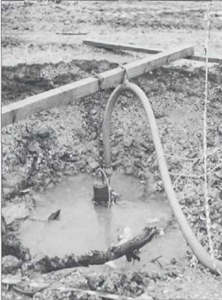
Figure 5: Pompage des eaux dans un puisard. L'étang construit sur une ancienne décharge d'ordures ménagères montre des traces de déchets dans le trou (septembre 1993).
