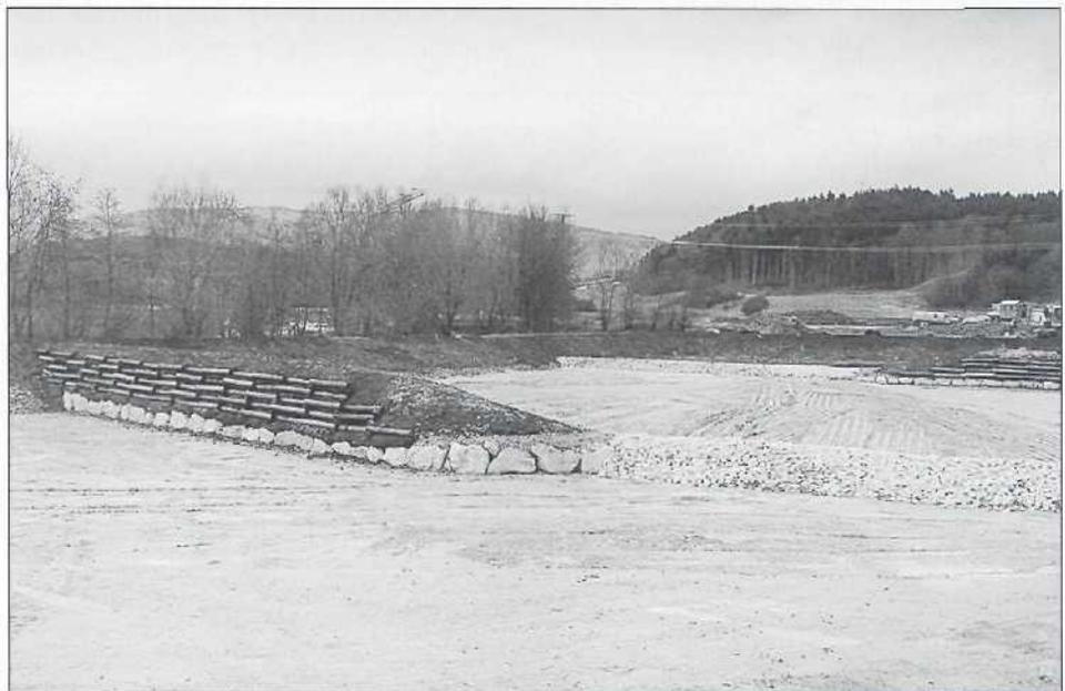
Figure 10: Travaux principaux terminés. L'étang est prêt pour la mise en eau. On distingue bien les épis qui obligent l'eau à suivre un trajet horizontal sinueux et les digues filtrantes qui obligent l'eau à un parcours en verticalité [décembre 1993].
