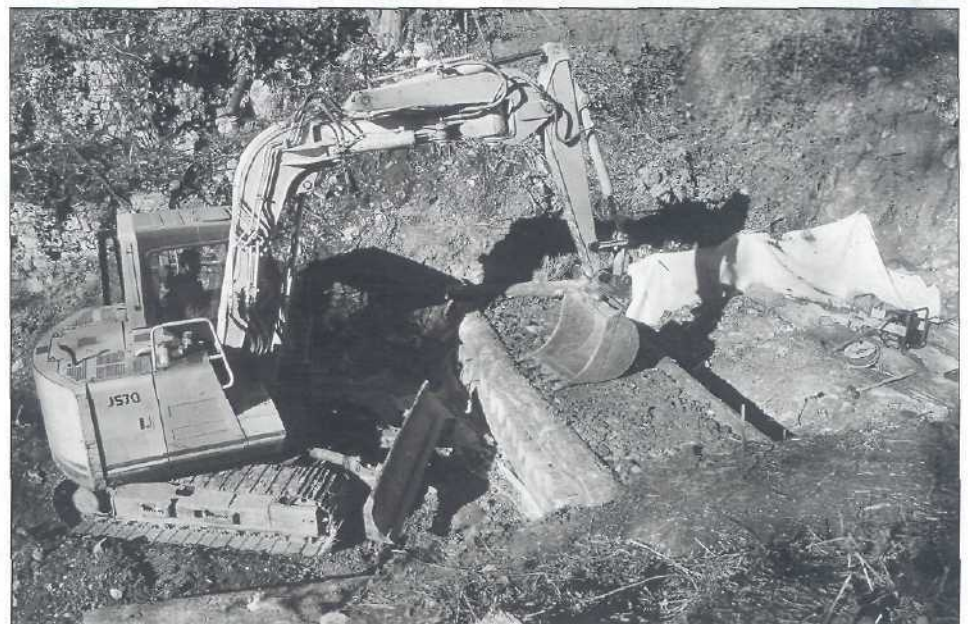
Figure 3: (24.02.99) Barrage-bois en cours de réalisation. On distingue, à droite, le géotextile bentonitique qui doit assurer l'étanchéité du ruisseau et qui est intégré dans les ouvrages.
