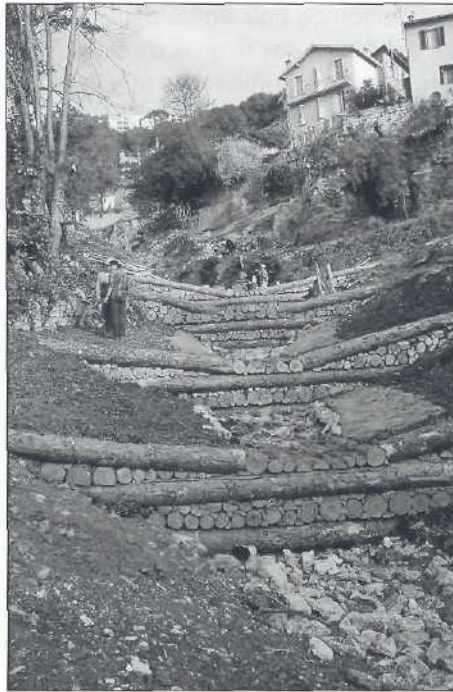
Figure 2: (10.03.99) 15 barrages-bois sont répartis sur le tronçon pour en stabiliser le profil en long.
