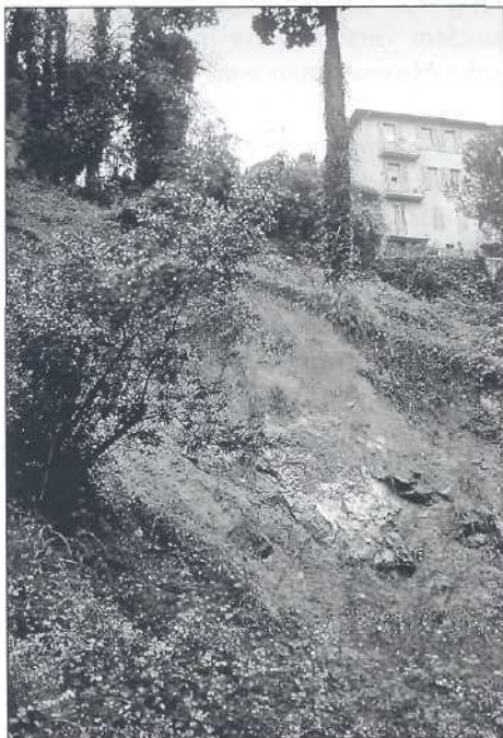
Figure 1: (07.04.98) Vue sur un secteur du site d'étude avec un exemple de glissement de terrain sur sol argileux, avec blocs de gypse affleurant. Abbildung 1: {07.04.98} Sicht auf einen Abschnitt des untersuchten Gebietes mit einem Beispiel eines Erdrutsches auf lehmigem Boden, mit anstehenden Gipsblöcken.
