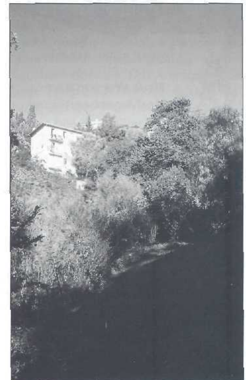
Figure 6: (24.09.02) Vue sur le réaménagement du lit du Rossignol; les barrages-bois disparaissent sous la végétation installée.
