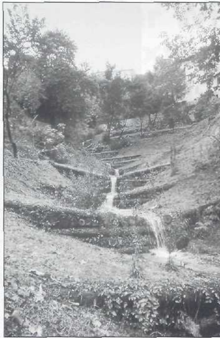
Figure 5: (21.10.99) Vue sur une partie du vallon, lors de la première période de végétation qui a suivi le chantier. On remarque que les ailes des barrages-bois vont s'ancrer profondément dans le terrain. Cette caractéristique, en plus d'améliorer la stabilité des ouvrages, permet de les intégrer harmonieusement dans le relief général du vallon. Intégration encore renforcée par les aménagements végétaux en plein développement.
