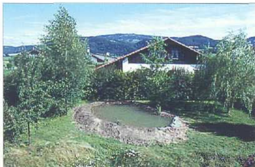
Figure 13. Remplissage : on voit l'augmentation du niveau et de la surface grâce à la digue qui ceinture l'étang.
