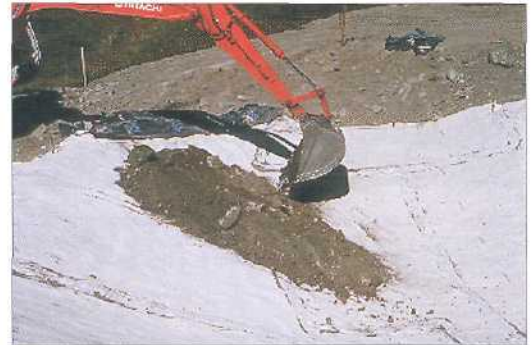
Figure 4. Mise en place de matériaux terreux sur une étanchéité minérale.
