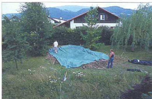
Figure 12. Mise en place de la bâche plastique. La bonne qualité du soi a permis l'emploi de ce type d'étanchéité avec des coûts moindres.
