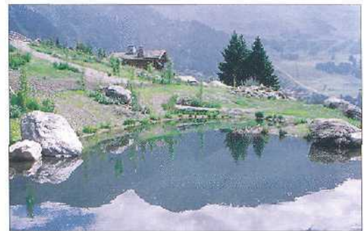
Figure 5. Etat juste à la fin des travaux, après la mise en eau et après les plantations.
