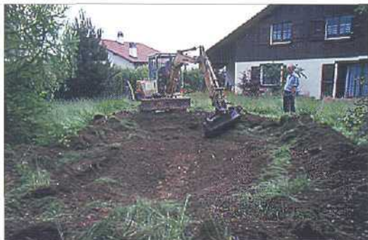
Figure 11. Etang en phase de creusage à l'aide d'une petite pelle hydraulique. Les déblais sont organisés en remblais sous forme de petites digues. Ceci permet de ne pas évacuer de matériaux et de diminuer ainsi les coûts.
