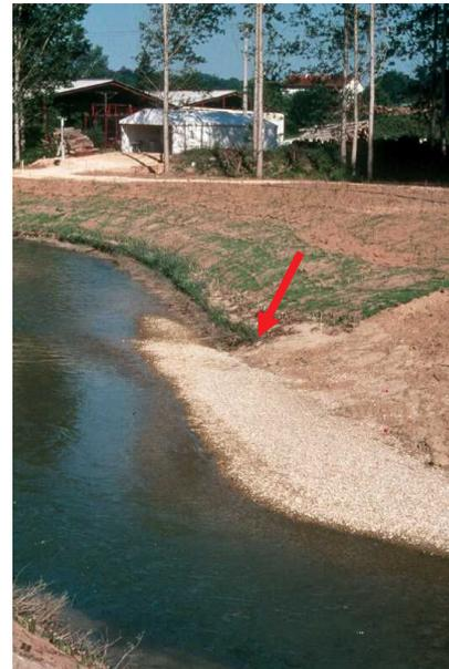
**Figure 11d.** Les premières crues ont confirmé les hypothèses de projet, à savoir la non nécessité de stabiliser les rives convexes avec des techniques particulières. En effet, on observe que les dépôts de graviers, liés à la dynamique alluviale, se font naturellement là où ils avaient été prévus, soit à la fin des ouvrages de génie végétal (flèche) (7.6.96).
