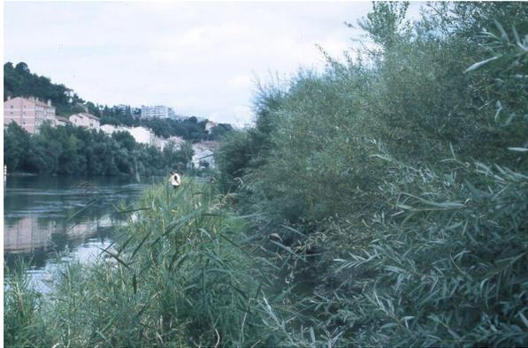
**Figure 12e.** L'ouvrage de génie végétal offre, maintenant, des caractéristiques biologiques très fonctionnelles, des caractéristiques paysagères et récréatives très prisées (pêcheurs et promeneurs) et, techniquement, une garantie idéale et durable contre l'érosion de la berge (11.9.98) !
