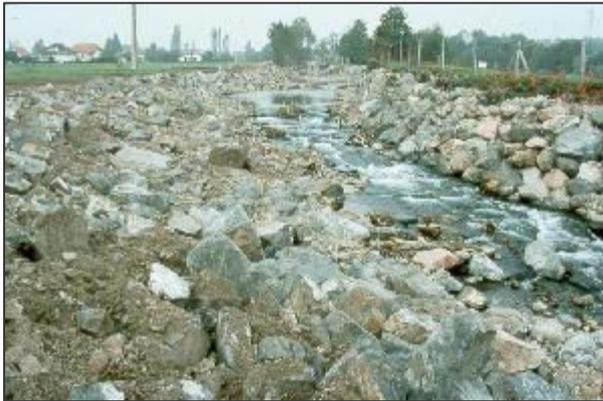
*Figure 2. Les corrections systématiques de cours d'eau avec des enrochements constituent des simplifications outrageuses et inacceptables du cours d'eau, conduisant immanquablement à des catastrophes écologiques durables, mais aussi à des catastrophes pour les collectivités riveraines.*
