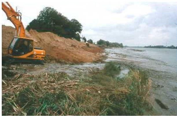
**Figure 10c.** Malgré le fait que les travaux doivent s'exécuter à marée basse, le risque d'enlèvement des machines dans la vase est permanent. En berge, le sol a été partiellement remplacé et préparé de manière à recevoir des végétaux, spécialement adaptés aux conditions de marée (niveaux d'eau) (4.11.97).
