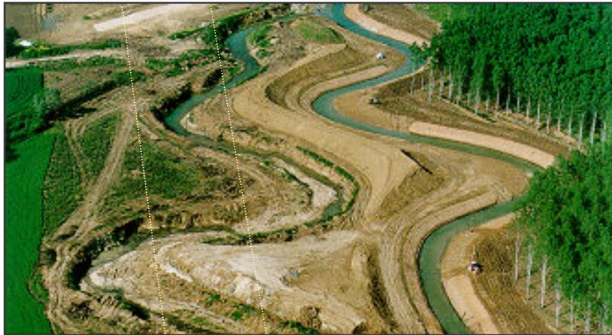
**Figure 9.** *La Lère (travaux mars-mai 1996) : déplacement complet du cours d'eau à Réalville dans le cadre de la réalisation de l'autoroute A20 BRIVE-MONTAUBAN (ligne pointillée) pour le compte d'ASF dans le Tarn et Garonne. L'ancien lit de la rivière côtoie, avant réaménagement, le nouveau tracé dont la morphologie initiale a été respectée. Délimite la future autoroute (Photo : MASTER PHOT mai 1996).*
