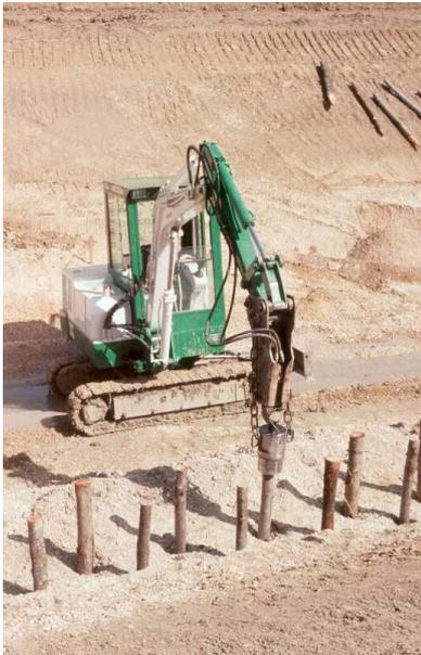
**Figure 11c.** Mise en place des techniques végétales. Ici une fascine de saules, avant la mise en eau du nouveau cours d'eau (25.3.96).
