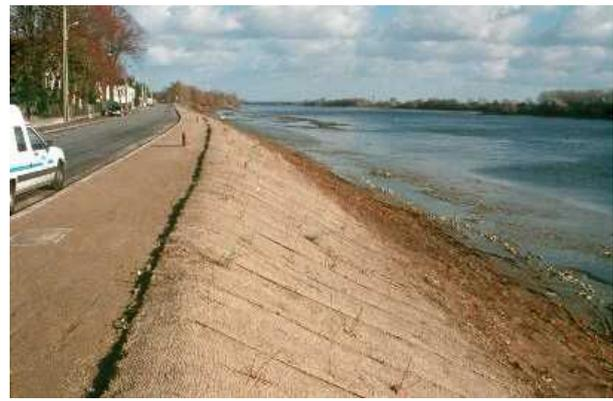
**Figure 10d.** Ouvrage terminé. On distingue les géotextiles de coco qui ont été mis en place et fixés. Des mottes d'hélophytes ont été placées en pied de berge entre les mailles, des ligneux, sous forme de boutures, ont été implantés en sommet de berge de manière à obtenir une zonation végétale typique de la Loire estuarienne (2.12.97).
