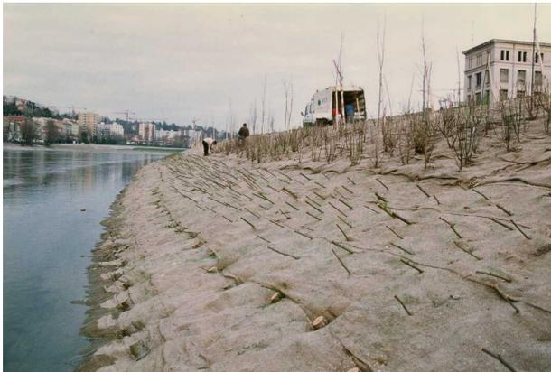
**Figure 12c.** Fin des travaux portant sur plus de 600 m de berge. Une répartition des ligneux a été opérée selon les séries végétales observables sur le Rhône (14.3.94).
