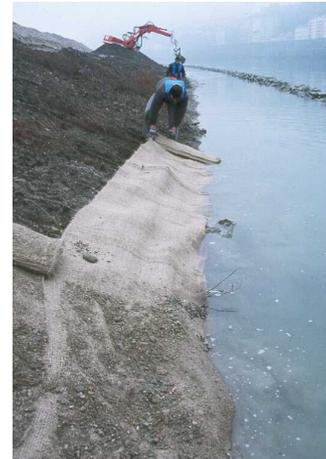
**Figure 12b.** Mise en place des techniques végétales en bas de berge, ici des couches de branches et du géotextile (24.1.94).
