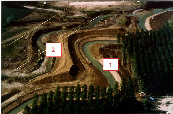
**Figure 11a.** Vue aérienne du site. Le nouveau tracé du cours d'eau (1) épouse le plus parfaitement possible l'ancien tracé (2). Les lignes délimitent la future autoroute.
