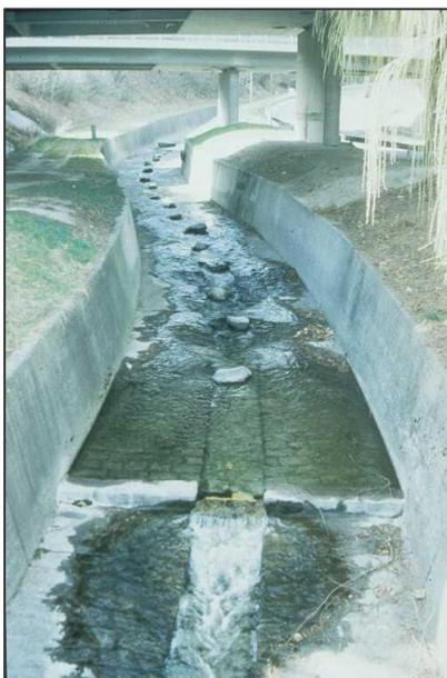
**Figure 1.** Des cours d'eau chenalisés et contraints dans des parois artificielles sont morts. Pour diversifier les écoulements et éventuellement permettre à quelques poissons "sportifs" de circuler, des pierres ont été mises en place au centre du canal !
