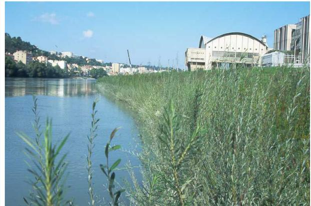
**Figure 12d.** Vue d'ensemble de la protection de la berge, 6 mois après la fin des travaux. L'ancien palais des congrès et Interpol sont visibles sur la droite (27.9.94).
