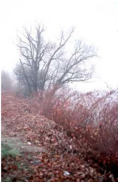
**Figure 10a.** Le haut de la berge érodé, régulièrement rechargé avec des matériaux de remblais caillouteux, a été complètement envahi par une espèce exotique invasive (*Fallopia japonica*) n'offrant aucune protection contre l'érosion (13.12.96).
