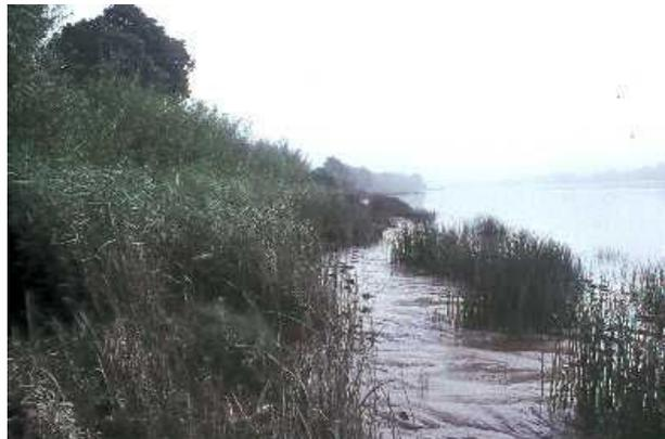
**Figure 10f.** Etat de la berge deux saisons végétatives après les travaux (vue amont). Le développement des hélophytes permet de retenir les vases lors du retrait de la marée. Cela contribue à structurer le paysage et à diversifier les séries végétales selon les modèles naturels (9.9.99).
