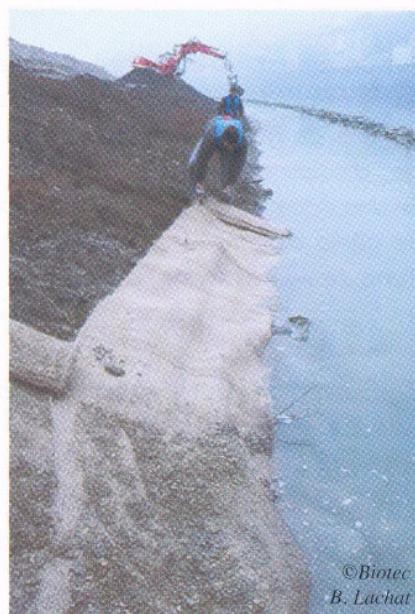
Mise en place des techniques végétales en bas de berge, ici des couches de branches et du géotextile (24. 1. 94).
