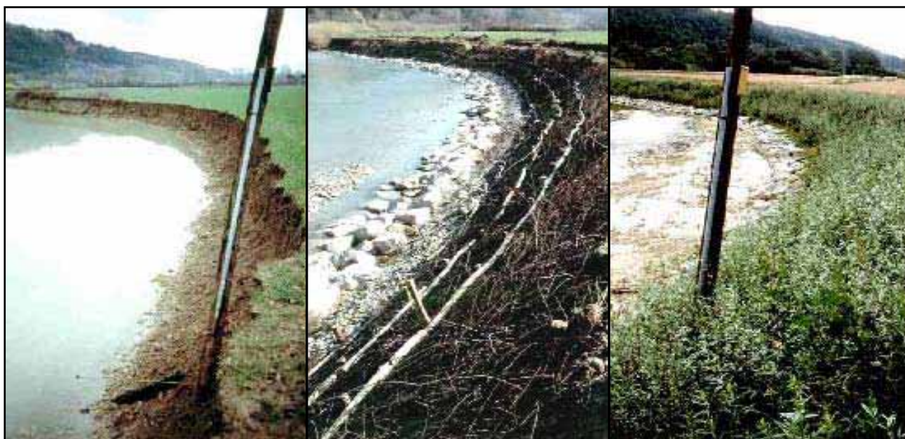
Figure 66. Rivière "Pesa" à Montelupo Fiorentino, province de Florence; illustration de technique végétale réalisée en protection de berge de cours d'eau; illustration de gauche avant les travaux, au centre en chantier puis à droite lors de la reprise végétale. Source : bureau IRIS, stratégie pour l'environnement, Maurizio Bacci ( www.irisambiente.it ).
