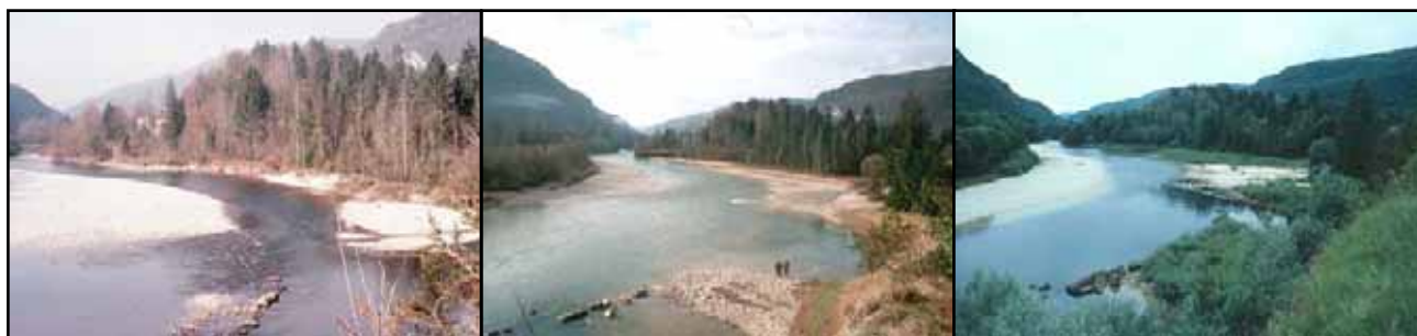
Figure 38. Vues de travaux de reconstitution de berges par des techniques indirectes (déflecteurs) sur la Bienne. La végétation riveraine adaptée est ainsi partiellement spontanée sur les dépôts favorisés par les épis (illustration de gauche avant travaux, au centre en fin de travaux et à droite 4 ans plus tard) (photos Biotec).
