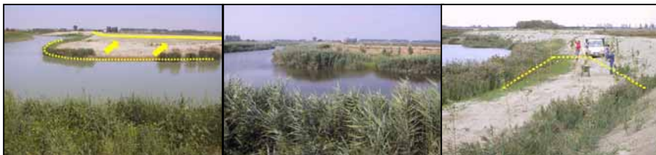
Figure 69. Restauration et report de digues sur la rivi re "Zero", dans le but de r duire les apports de nutriments dans la lagune de Venise, en am liorant les capacit s auto puratoires des formations v g tales riveraines (source : photos B. Baldo, de la part de Bruno Boz, CIRF; Centro Italiano per la Riqualificazione Fluviale : www.cirf.org ).
