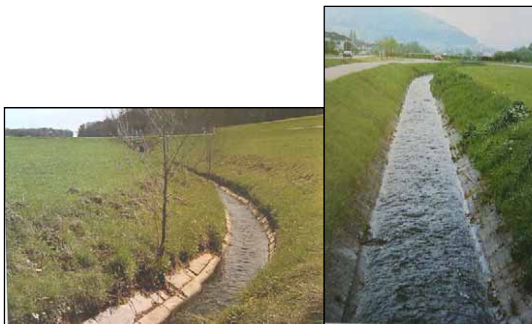
Figure 45. Exemple de rivières chenalisées en Allemagne. (Handbuch Wasserbau, 1992).
