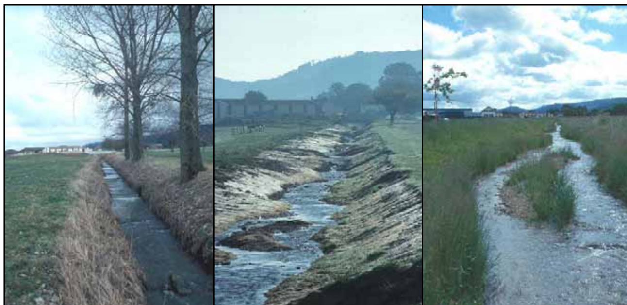
Figure 61. A gauche : (14.02.00) Etat de la Cornoline avant travaux avec pieds de berge et seuils en béton, tracé rectiligne et végétation très peu diversifiée. Au centre : (27.09.01) Etat à la fin des terrassements avec la création de berges en pente douce et variées, ainsi que la création d'îlots. A droite : (10.06.02) Etat une année après les travaux avec le développement des plantes hélophytes (semi-aquatiques) qui permettent de stabiliser les pieds de berge et de diversifier la flore locale (photos Biotec). Niveau d'ambition R2.
