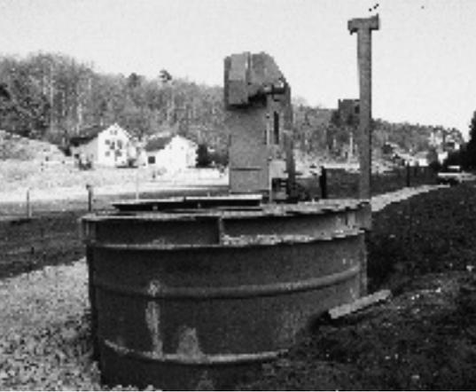
Photo 1 : Poste de refoulement N° 1 après installation. Le dégrilleur automatique est aussi installé (24.03.03).
