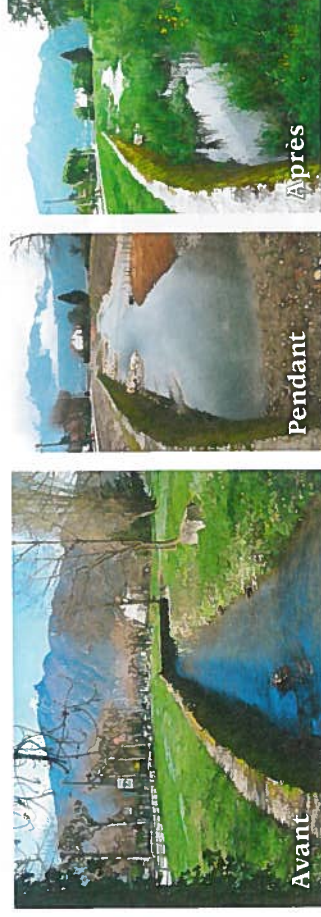
Figure 5 : Diversification du lit au niveau geomorphologique et habitats. La création du nouveau lit du Tillet, méandrique et avec un maximum de surfaces plantées d'hélophytes (rishermes basses, annexes hydrauliques, bras mort, etc.), s'est effectuée dans un but d'amélioration de la qualité de l'eau.
