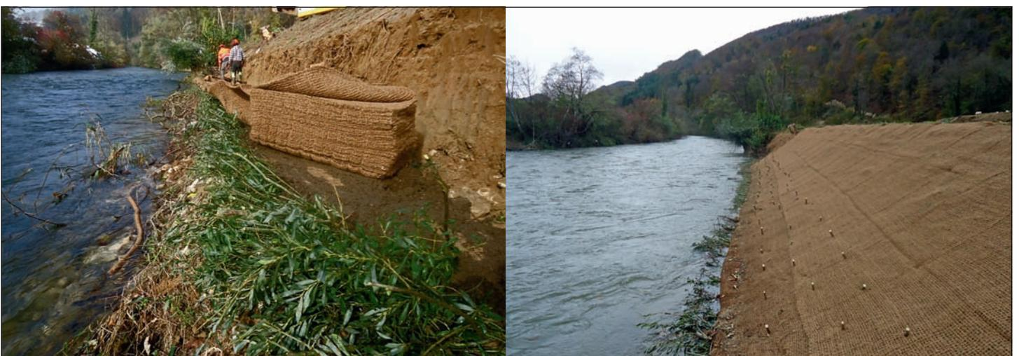
Fig. 11 : Lit de plançons en construction (gauche) et vue de la berge à la fin des travaux (droite) (photos Biotec).
