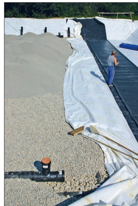
Fig. 2 : 1 er étage de traitement en construction où l'on distingue l'étanchéité (bâche noire), les différentes couches de graviers calibrés et le système de drainage/aération (juillet 2005).
