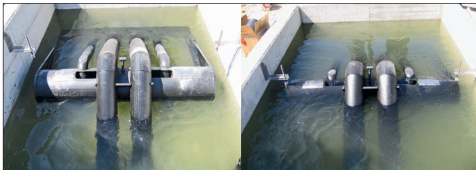
Fig. 4 : Siphon auto-amorçant ; à gauche le siphon flotte tant que le volume d'une bâchée n'est pas atteint ; à droite, un système de butée bloque le siphon, ce qui provoque le remplissage du flotteur et permet l'amorçage du siphon, environ 8 m 3 d'eau sont évacués « sous pression » en direction des filtres.
