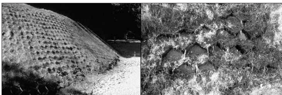
Fig. 9: Système cellulaire permettant de mettre de la terre végétale et de l'herbe sur des substrats bruts. La richesse du substrat a fait se développer de façon exubérante des graminées alors qu'on aurait pu ensemercer le talus brut avec un mélange grainier riche en fleurs, adapté à ce type de sols et d'exposition. Ces systèmes vieillissent malheureusement très mal (Photos Biotec).
