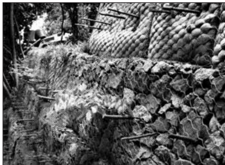
Fig. 4: Image tirée de la même plaquette que précédemment. On a vraiment du mal d'imaginer qu'il s'agisse de génie biologique et que les promoteurs utilisent cela comme modèle, même si des boutures sont plantées uniformément dans ... les cailloux!
